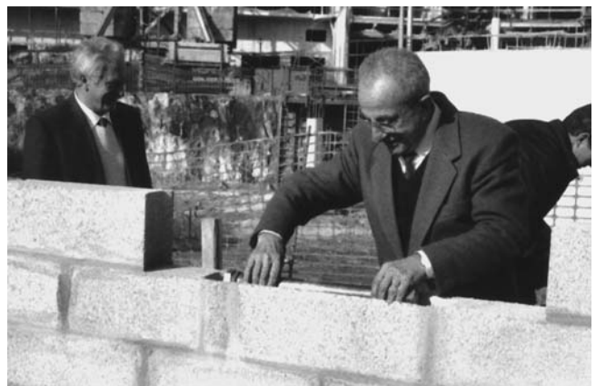
C. Scotto La Massèse, lors de la pose de la première pierre des installations nouvelles du Centre d'Antibes à Sophia-Antipolis (17 janvier 2003).
