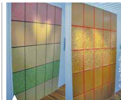
Panneaux «MDF relief» aux propriétés d'isolation acoustique.
